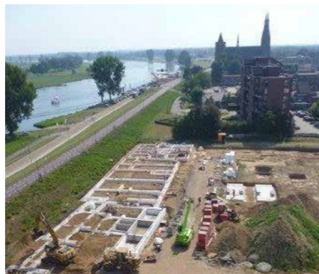
Storten vloer begane grond.
